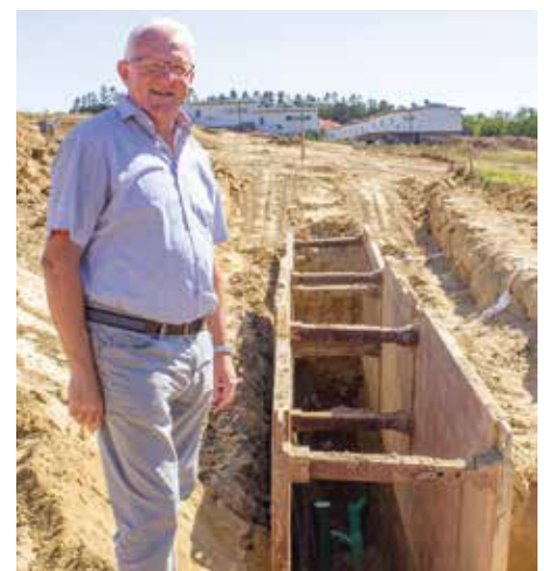
Fortschritt der Kanalbauarbeiten im neuen Siedlungsgebiet
