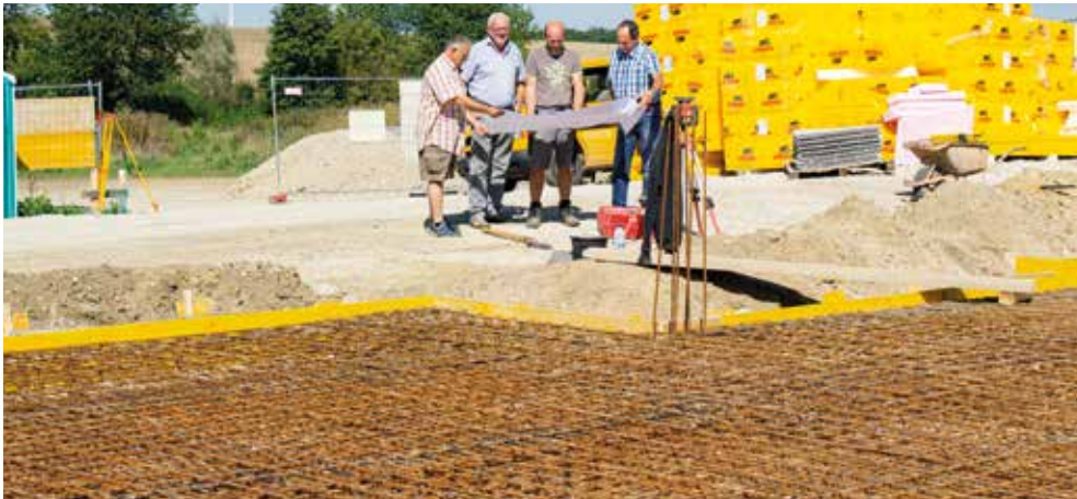
Baubesprechung auf der Baustelle des Kindergartens Schrick
