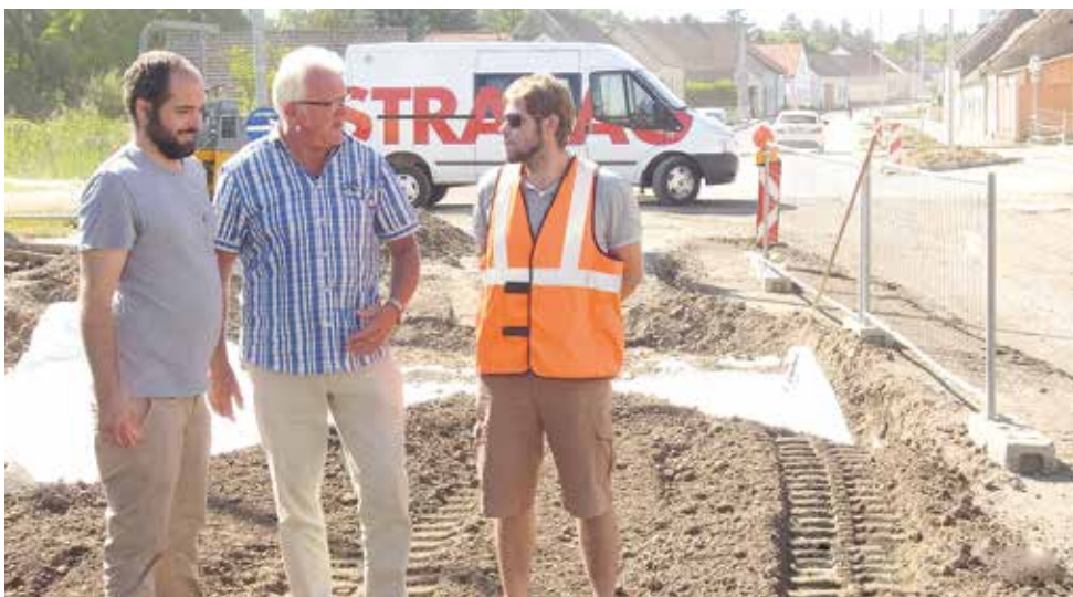
Bgm. Richard Schober mit Ing. Michael Böhm (Bauleiter STRABAG) und Ing. Anton Holzmüller (STBA3) bei der Baubesprechung auf der B 7
