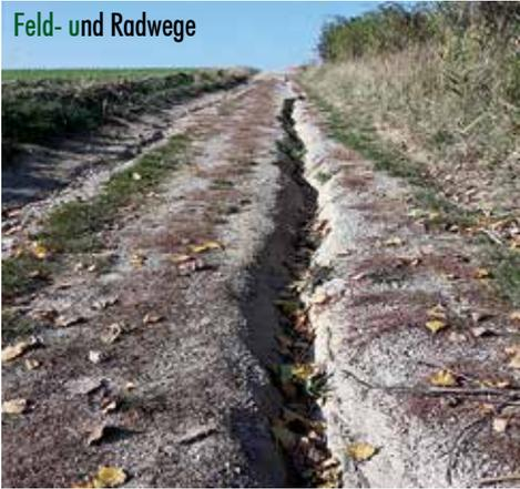
wurde bei Starkregen mehrmals Erde angeschwemmt. Somit war der ordnungsgemäße Ablauf des Regenwasser nicht mehr gegeben. Mitte Oktober wurde in den betroffenen Teilbereichen die angeschwemmte Erde entfernt und die Einläufe in Wasserableitungsgräben verbessert, um die Verkehrssicherheit zu gewährleisten. Für die Zukunft ist die Errichtung eines Hochwasserschutzes geplant.
