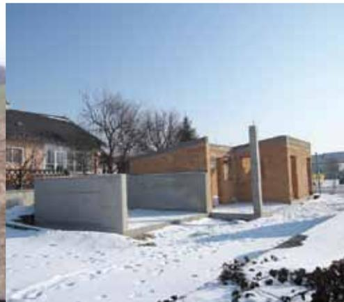
Im November 2011 wurde mit den Planierarbeiten für die Erweiterung des Friedhofes in Gaweinstal begonnen. Das Gelände musste bis zu 1 Meter abgesenkt werden. Um die Bodenbeschaffenheit für die Fundamente der Friedhofsmauer festzustellen, wurden 6 Probeschlitze vorgenommen und anschließend das Mauerfundament bis zu einer Tiefe von 2,8 Meter betoniert.
