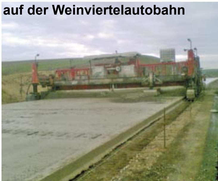
Zügig schreiten die Arbeiten an der A5 Baustelle voran. An den zwei Bildern sieht man, wie zuerst eine dünne Asphaltschicht aufgetragen und dann die Fahrbahnbreite der Autobahn auf einmal betoniert wird. Täglich werden 800 Laufmeter hergestellt. Die Eröffnung der A5 von Schrick bis inklusive S1 - Ost und West, das heißt kreuzungsfreier Anschluss an die Süd- und Westautobahn, ist mit Frühjahr 2010 geplant.
